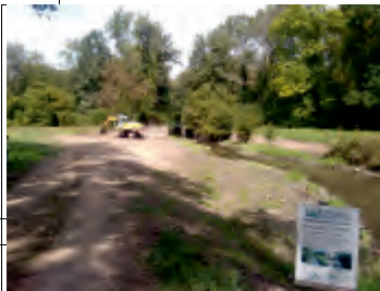
L'Andlau, au même endroit : les bancs en graviers, terre et bois réduisent la largeur en eau
